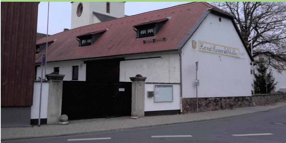
Abbildung 21 Denkmalgeschütztes Einzelgebäude, Heimatmuseum, Baualtersklasse vor 1919 (eigene Aufnahme IU)
