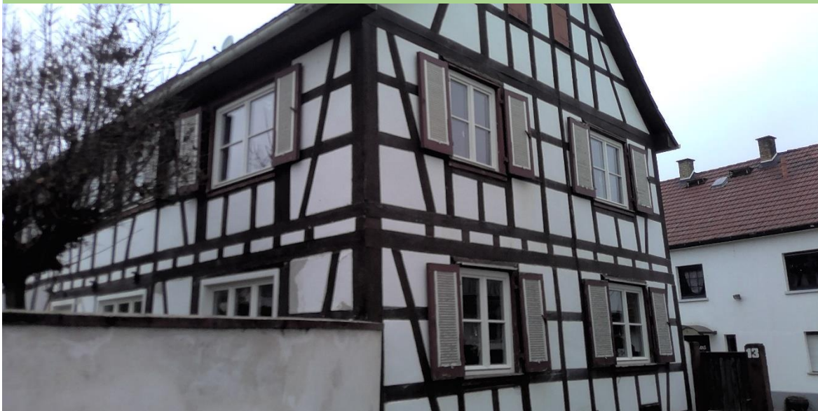
Abbildung 19 Denkmalgeschütztes Einzelgebäude, Wohngebäude, Baualtersklasse vor 1919 (eigene Aufnahme IU)
