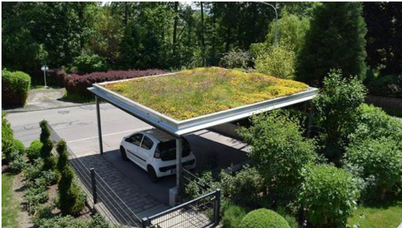
Abbildung 89 Beispiel eines begrünten Carports zur Steigerung der Verdunstungsleistung und Schattenspende (VBZ. NRW 2021)
